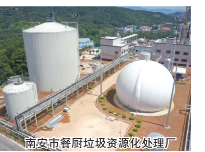
南安市餐厨垃圾资源化利用厂。
