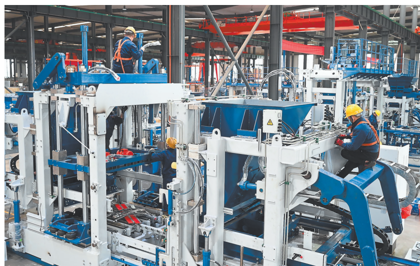
近期,福州、泉州、厦门等多地政府帮助企业“组团”赴境外参加经贸活动,外贸企业生产忙、信心足,全力冲刺“开门红”。图为福建泉工股份有限公司工作人员在安装销往海外的全自动砌块成型机。林善传 摄
