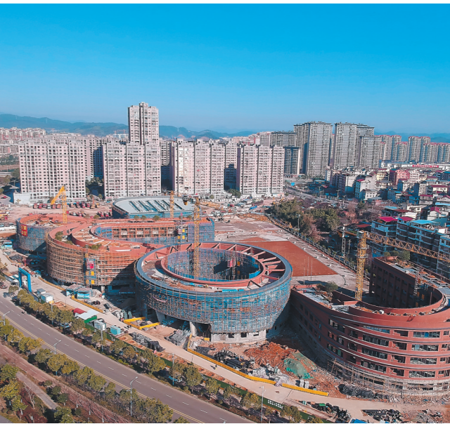
春节假期过后,各地建设项目“加速度”,奋力实现“开门红”,项目施工现场工人铆足干劲,一派繁忙。因为1月30日拍摄的南平市第三实验学校建设项目施工现场。 新华社
