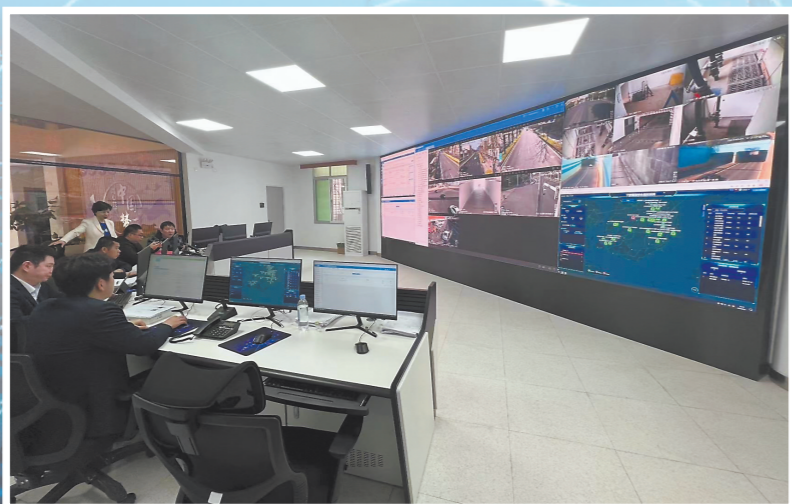
厦门市智慧市政运行指挥监控中心。(资料图片)
