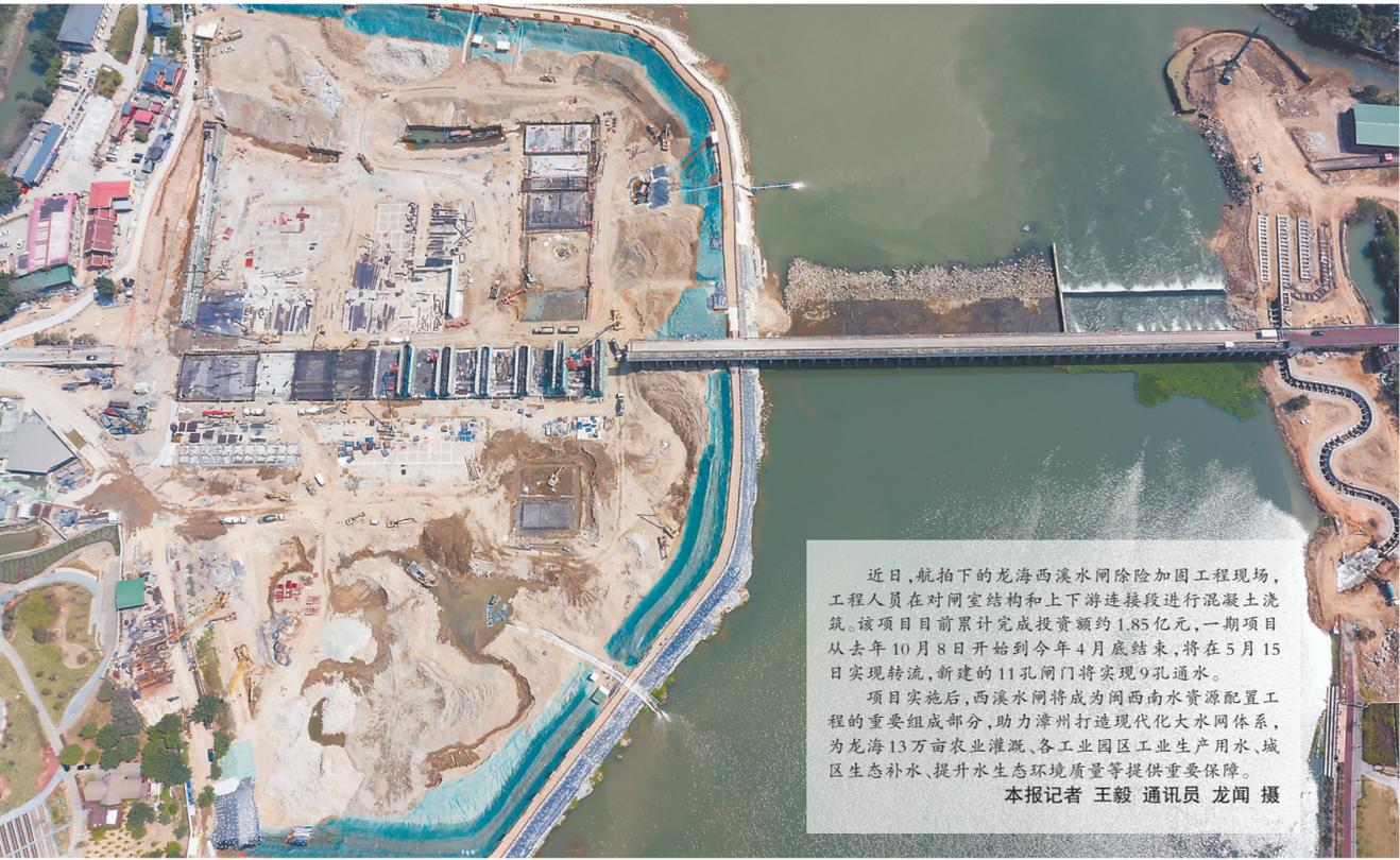
近日,航拍下的龙海西溪水闸除险加固工程现场,工程人员在对闸室结构和上下游连接段进行混凝土浇筑。该项目目前累计完成投资额约1.85亿元,一期项目从去年10月8日开始到今年4月底结束,将在5月15日实现转流,新建的11孔闸门将实现9孔通水。项目实施后,西溪水闸将成为闽西南水资源配置工程的重要组成部分,助力漳州打造现代化大水网体系,为龙海13万亩农业灌溉、各工业园区工业生产用水、城区生态补水、提升水生态环境质量等提供重要保障。
