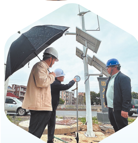
今年4月25日,“一闸三线”工程土建五标段的输水管道进行水压试验。
