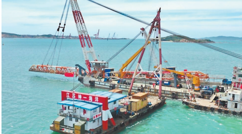
“一闸三线”工程平潭段进行海上施工。(资料照片,受访者供图)
