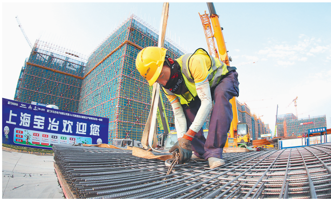
厦门天马微电子第8.6代新型显示面板生产线项目工地上,工人正在吊装钢筋。林梓健 摄
