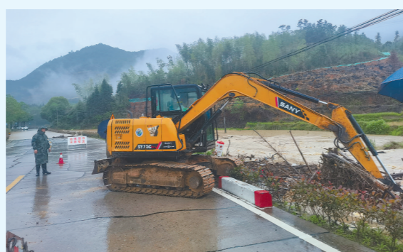
公路部门在邵武市下沙镇胡书村322国道清沟排水。
