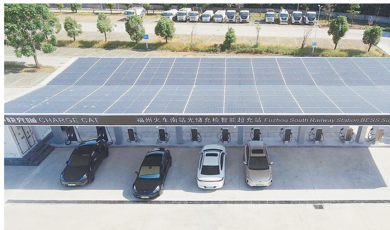
位于福州火车南站的光储充检智能超充站
