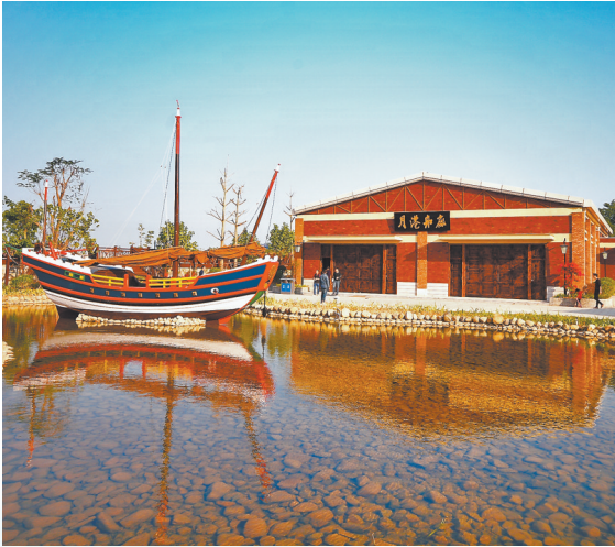
月港船厂依然传承着木帆船和龙船的建设。
