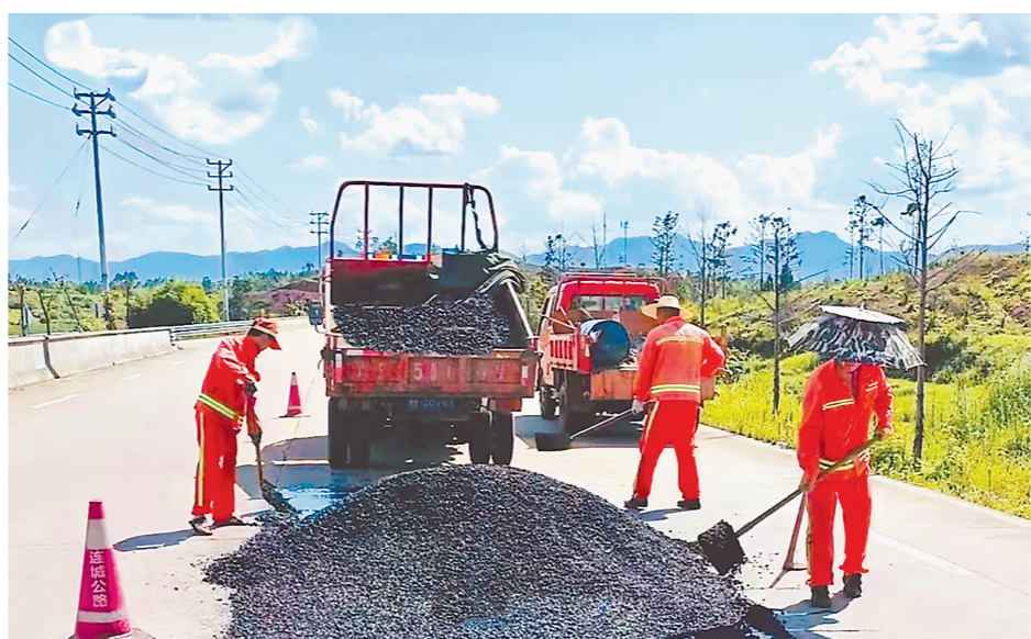
养护工人对破损路面进行沥青摊铺。
