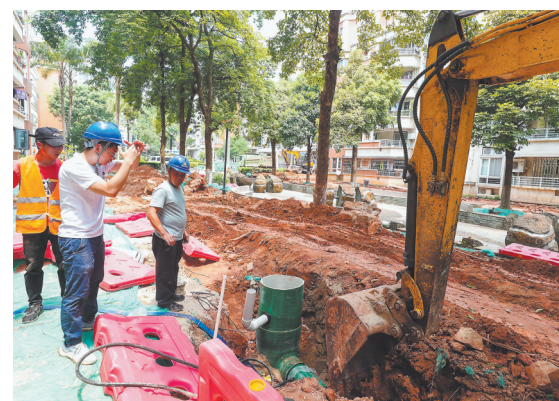
今年芗城区共投入4.6亿元对67个老旧小区进行改造,改造规模居全市首位。目前已完成7个小区改造,其余60个小区也已全部进场施工。图为近日,工人在华元小区改造现场进行管线开挖作业。 郑文典 欧阳智煌 摄
