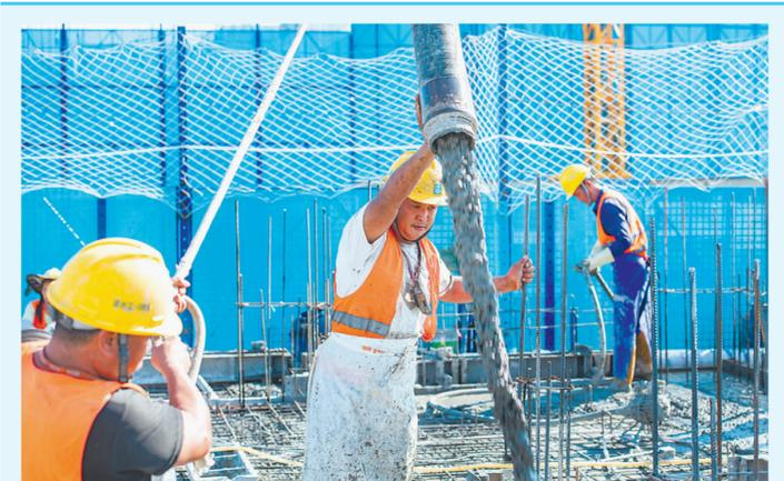
近日,在惠安县泉惠片区安置房项目施工现场,工人忙着绑扎钢筋、浇筑混凝土等工序,加快推进项目建设。
