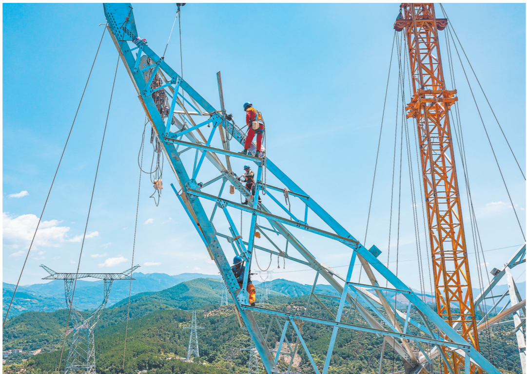
近来,福建北电南送特高压交流输电工程进入施工高峰期,该工程是国家“十四五”电力规划重点工程,计划12月建成投产。图为近日,建设者在闽侯县攻坚冲刺全线最后一基铁塔。 本报记者 王永珍 通讯员 何炜 摄
