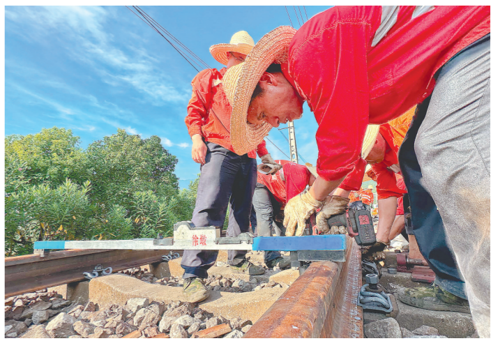
7月13日,中国铁路南昌局南平工务段作业人员在峰福铁路建瓯站进行更换钢轨施工,保障暑期运输安全。 本报记者 吴鹏 通讯员 吴志祥 摄
