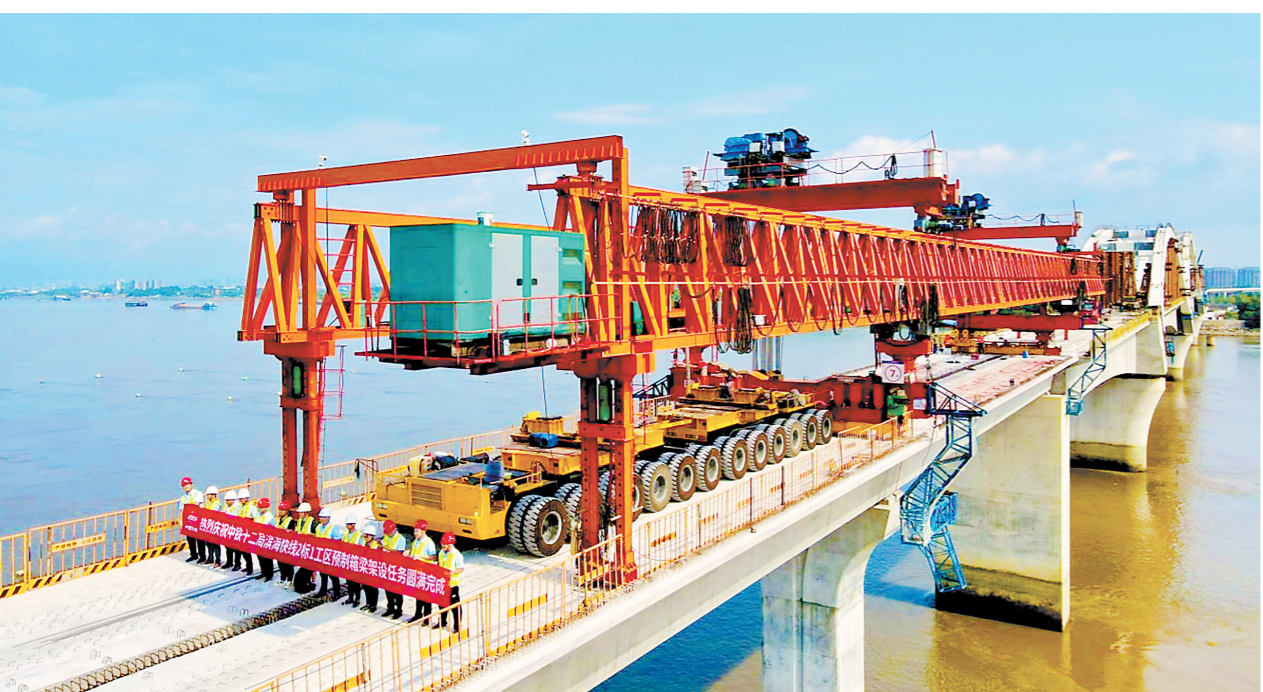
22日,随着最后一孔40米小箱梁顺利跨江架设,标志着由中铁十二局承建的福州至长乐机场城际铁路(滨海快线)帝封江站至祥谦站高架区间小箱梁架设任务圆满完成,为下一步轨道铺设奠定了基础。据悉,滨海快线是福州“一城双核”的快速轨道交通连廊,将确保滨海新城与中心城区实现快速互连互通。 曾剑锋 摄
