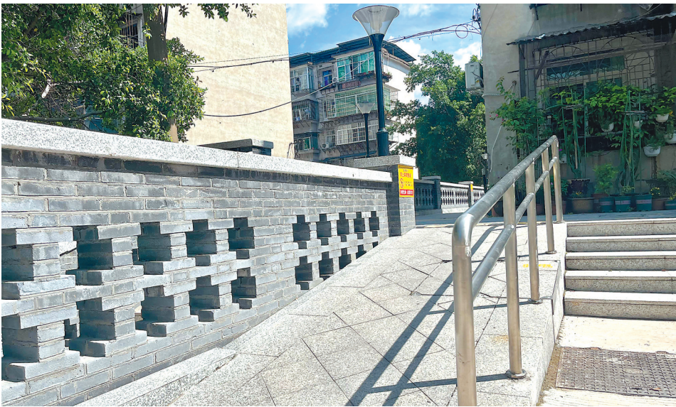
杜鵑新村为老年居民增设无障碍通道。
