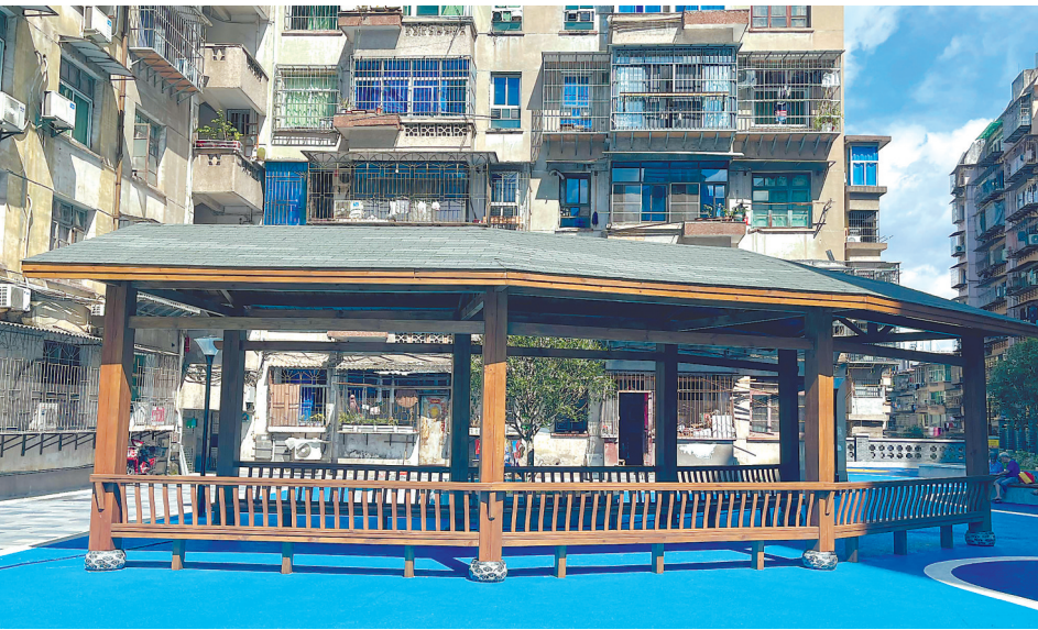
杜鵑新村新建风雨连廊,方便居民出行。
