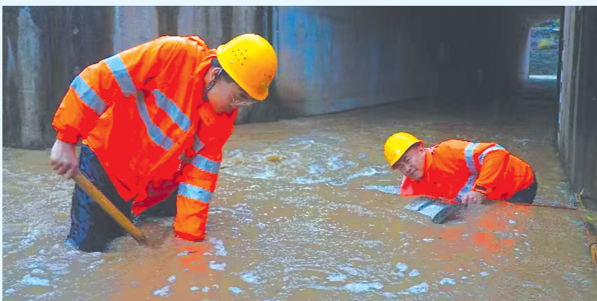
国铁南昌局水投永桥隧工人在疏通涵洞,确保排水通畅。潘友南 张颖 摄
