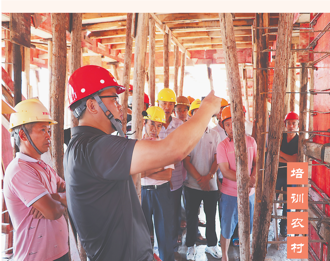
2日,龙岩市永定区第二期农村工匠培训举行,主办方组织农村工匠观摩云上庭院民宿项目,聘请高级工程师现场点评该项目的外墙脚手架、钢筋捆扎、砌砖、承重墙、模板、横梁等,总结农房安全事故经验教训,传授农村建房选址等专业知识。据介绍,这次培训有来自下洋、湖坑等乡镇的47人参训,包括泥水匠、瓦工、油漆工等工种。林志成 张河滨 摄影报道
