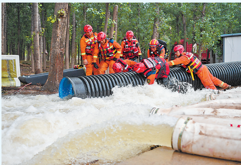
6日,在河北省涿州市刁窝镇东张村,唐山消防救援支队队员在进行排涝作业。当日,随着河北省涿州市部分受灾地区水势逐渐消退,当地居民、志愿者和消防救援人员在涿州市多个村庄开展清淤、消杀、排涝等灾后修复工作,争取将损失降到最低。 新华社
