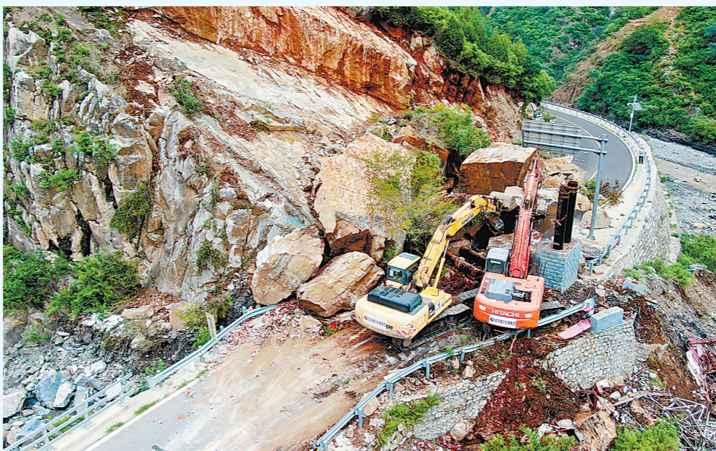
6日,在北京市房山区史家营乡金鸡台村附近,北京建机施集团的大型机械在清理阻断道路的落石(无人机照片)。
