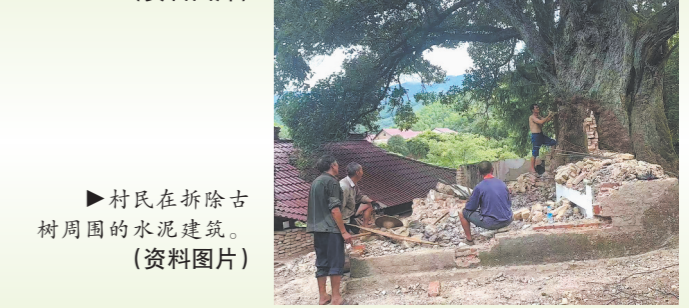
►村民在拆除古树周围的水泥建筑。(资料图片)
