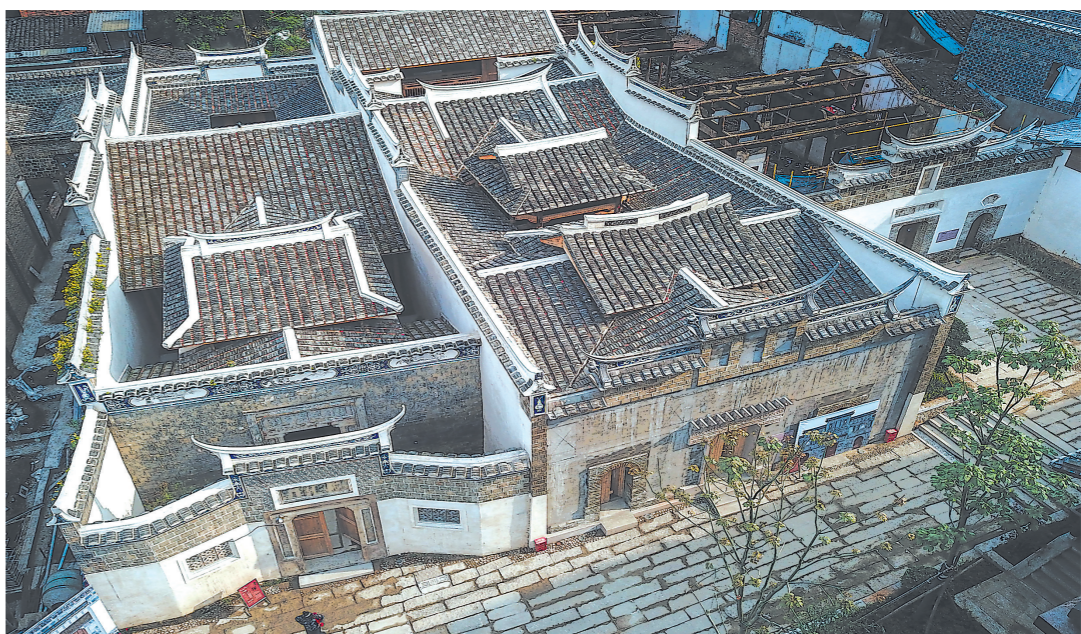
建瓯市铁井栏—紫芝街历史文化街区，古民居“修旧如旧”。
