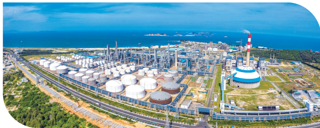
▲ 兴业银行持续加大对古雷石化产业基地全方位金融支持力度。
