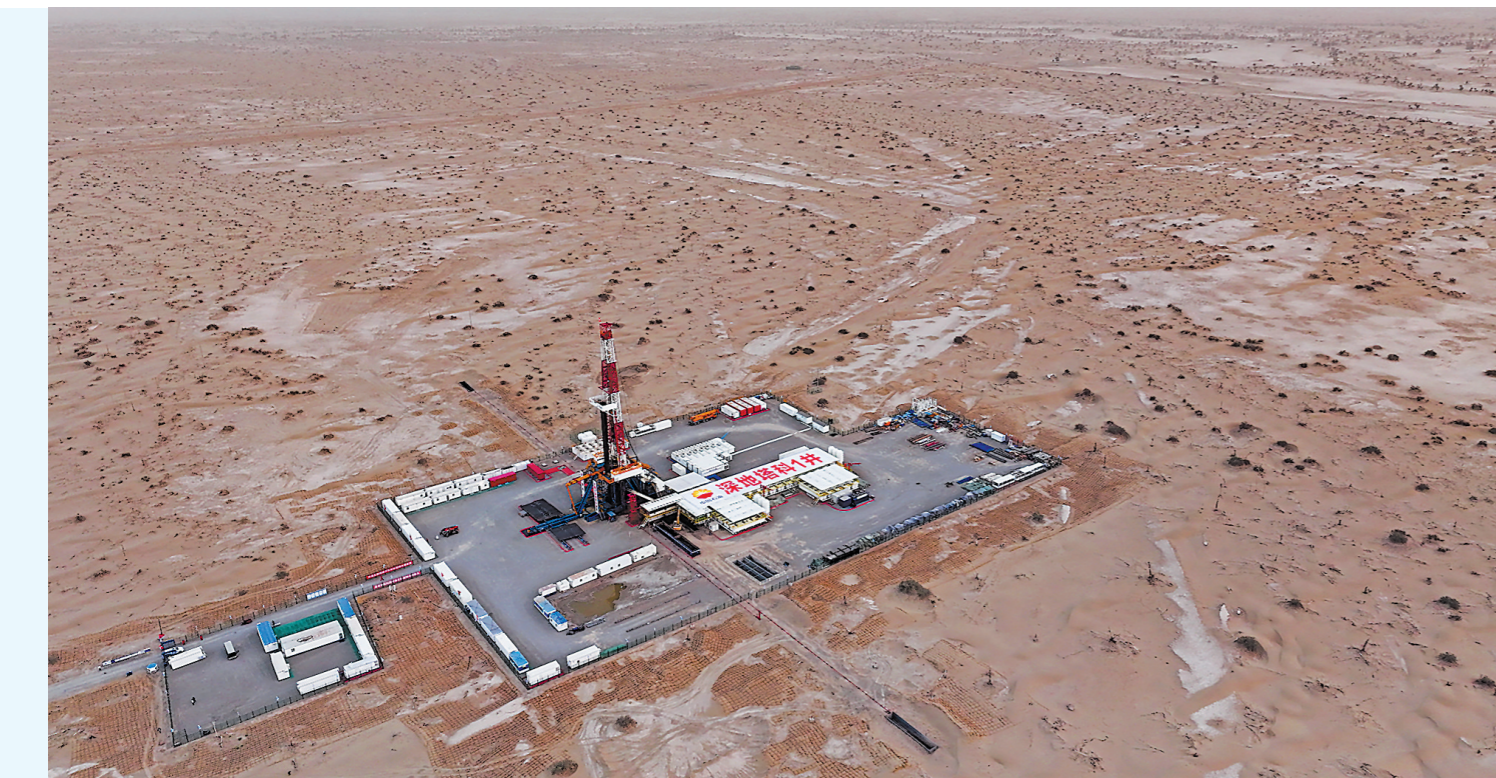
截至8月27日,“深地塔科1井”钻探深度已达到6000米。
