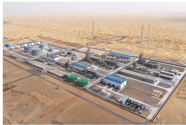
位于新疆塔里木盆地塔克拉玛干沙漠的中国石化“深地工程”——顺北油气田平均埋藏深度超过7300米,是世界陆上最深的商业开发油气田之一。顺北油气田目前已钻成垂直深度超过8000米的井50口,实现了26口“千吨井”(单井日产量1000吨的油气井)的重大突破。图为21日拍摄的顺北油田联合站。 新华社
