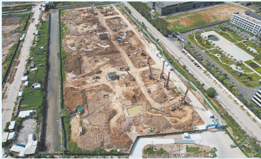
空中俯瞰东海鞋服科技产业园建设工地。(资料照片)
