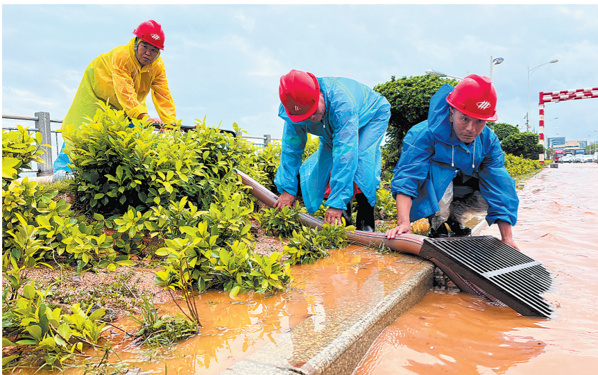
5日,厦门交通管理部门在抽排路面积水。 本报记者 陈挺 摄
