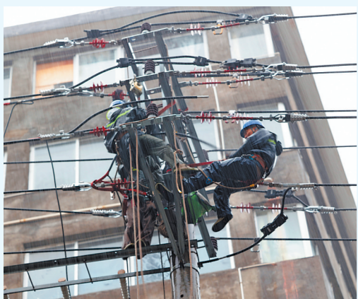
5日,国网德化县供电公司抢修人员冒雨快速恢复10千伏金北613线28号杆受损电力线路。 郑智得 周云中 黄琼芬 摄
