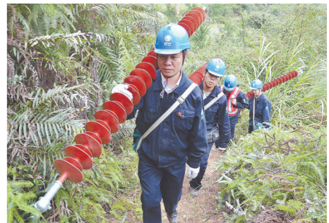
冯振波带领带电班职工翻山越岭赶赴带电作业现场。
