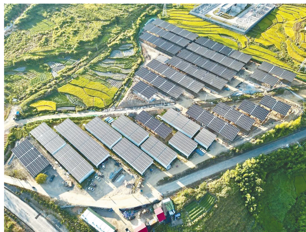
古田菇棚“光伏+”项目示范点 (资料图片)
