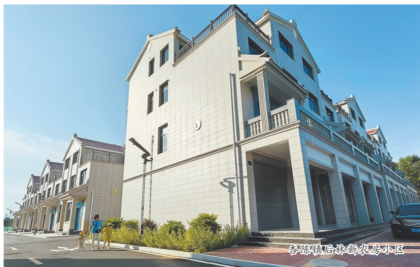
漂亮整洁的康美镇东沈村新房小区
