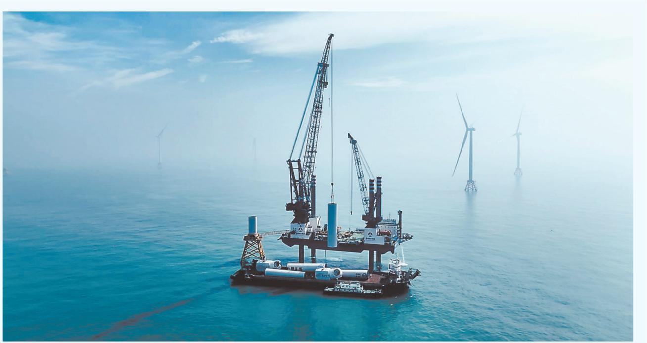
近日,在漳浦六鳌海上风电二期项目海上风电机组施工现场,工人从运输船上吊装风电塔筒及机舱。近来,施工方抢抓施工窗口期,加快设备安装调试,有望于年底并网发电。该项目是全国首个批量化采用13兆瓦及以上海上风电项目,预计每年可发电4000小时,年发电量16亿千瓦时,可节约标准煤50万吨。
