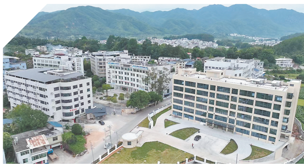
新桥中心卫生院新建成的业务大楼
