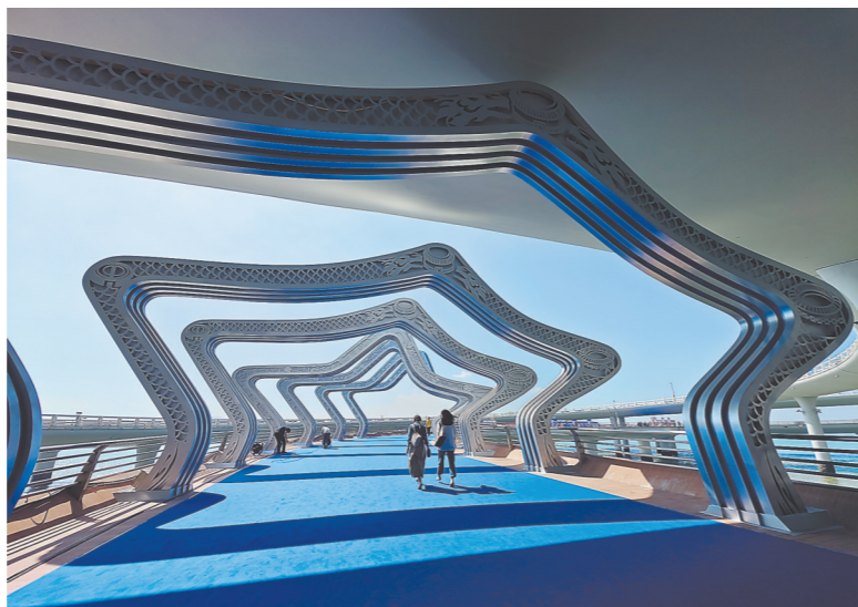
厦门演武大桥观景平台金鸡百花星光海岸成为网红打卡点。
