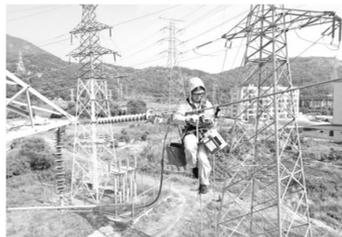
11月6日,国网福州供电公司输电带电作业人员在长乐区鹤上镇新庄村为110千伏旗桥线1号塔下相耐张线夹分流导线。
