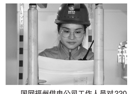
国网福州供电公司工作人员对220千伏塘头变110千伏GIS设备进行验收。
