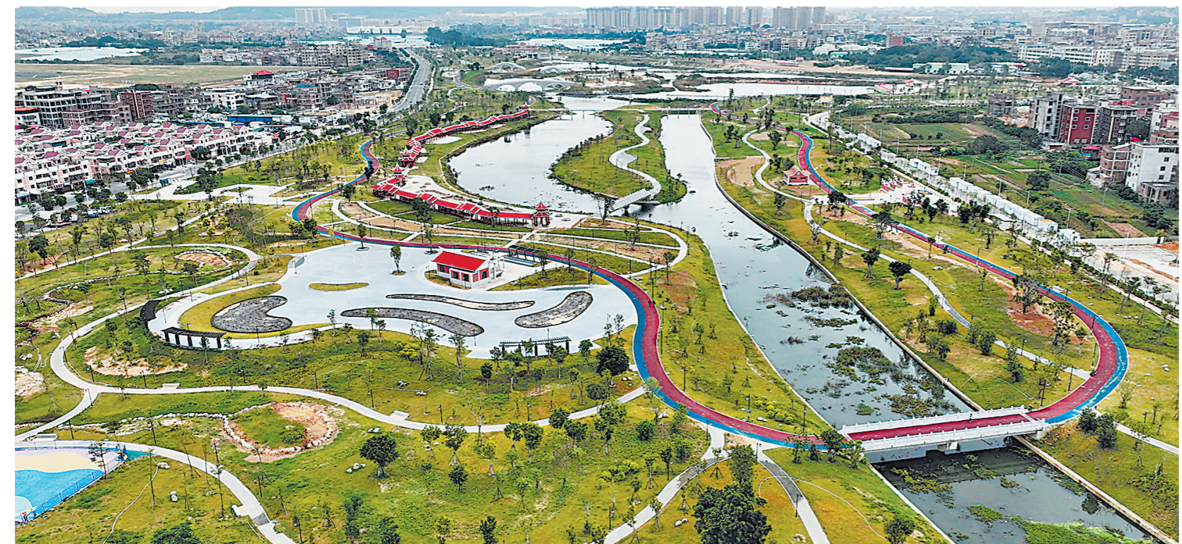
近年来,泉州各地在建设城乡公园中坚持绿色发展理念,因地制宜围绕城乡实施生态修复整治工程,打造“河畅、水清、岸绿、景美”的乡村生态景观,营造“推窗见景、出门见园”的城乡环境,让群众在家门口就能享受到绿色福祉。图为15日,位于泉州惠安县城的在建的惠安东湖公园雏形。 林升 摄
