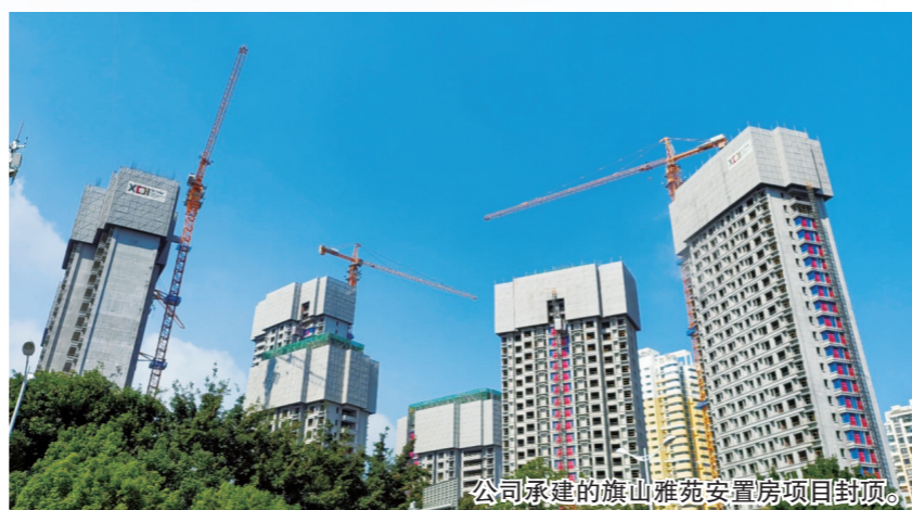
公司承建的旗山雅苑安置房项目封顶。2023年第三季度12345民生热点“每月一题”专项治理任务分工的通知,排查筲箕湖周边道路及岛内25条主干道,逐步将该项工艺向全市,甚至全省推广。
