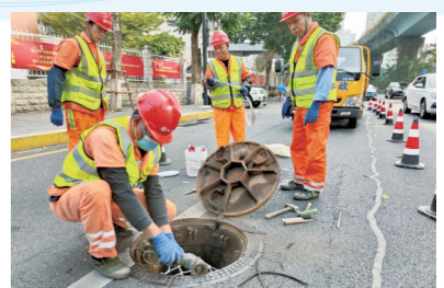
施工人员正在用新工艺维修井盖。
