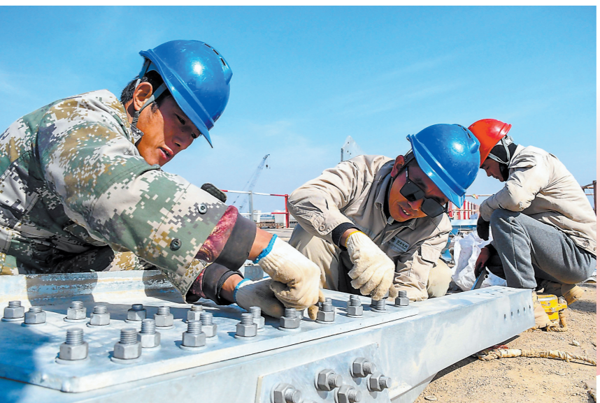
1日,在福清市江阴镇北郭村,国网福州供电公司施工人员正在赤厝至华塘220千伏线路跨越东港航道的34号塔的组立施工。为了加快建设进度,元旦期间,该公司60多名施工人员坚守岗位,克服海上风力大、有效作业时间短等不利因素,全力以赴确保工程按期推进。 据了解,赤厝至华塘220千伏线路工程建成后,可大幅提升江阴工业园区的供电可靠性,还能提高附近海上风电的送出能力。 本报记者 游庆辉 通讯员 陈燕 陈德钧 摄
