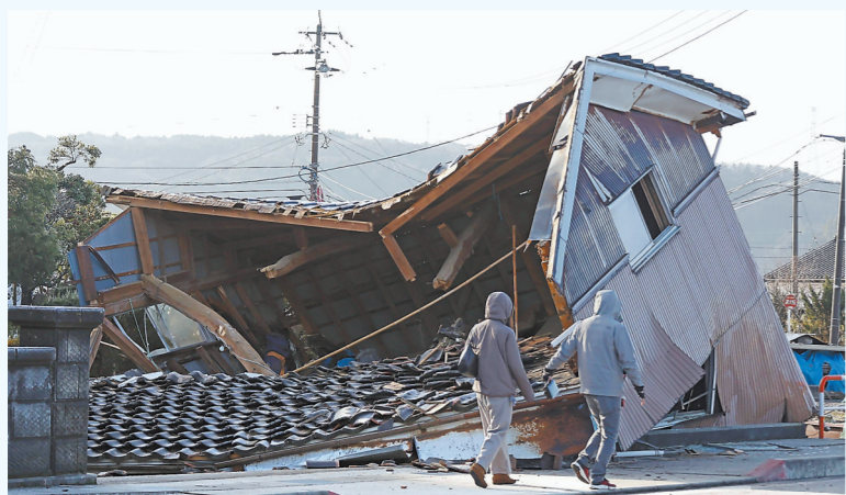
2日,在日本石川县鹿町,人们经过一栋倒塌的建筑。
