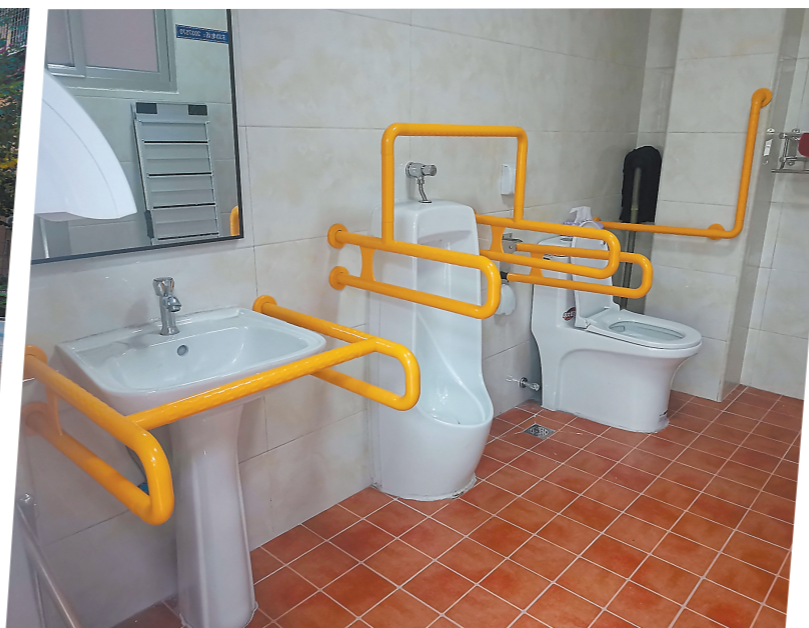
西桥街道鑫荣花园小区内的无障碍卫生间
