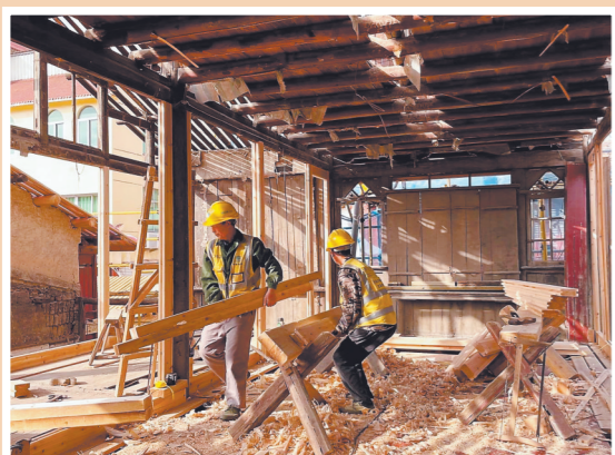
工匠运用传统工艺修复老建筑。(资料图片)
