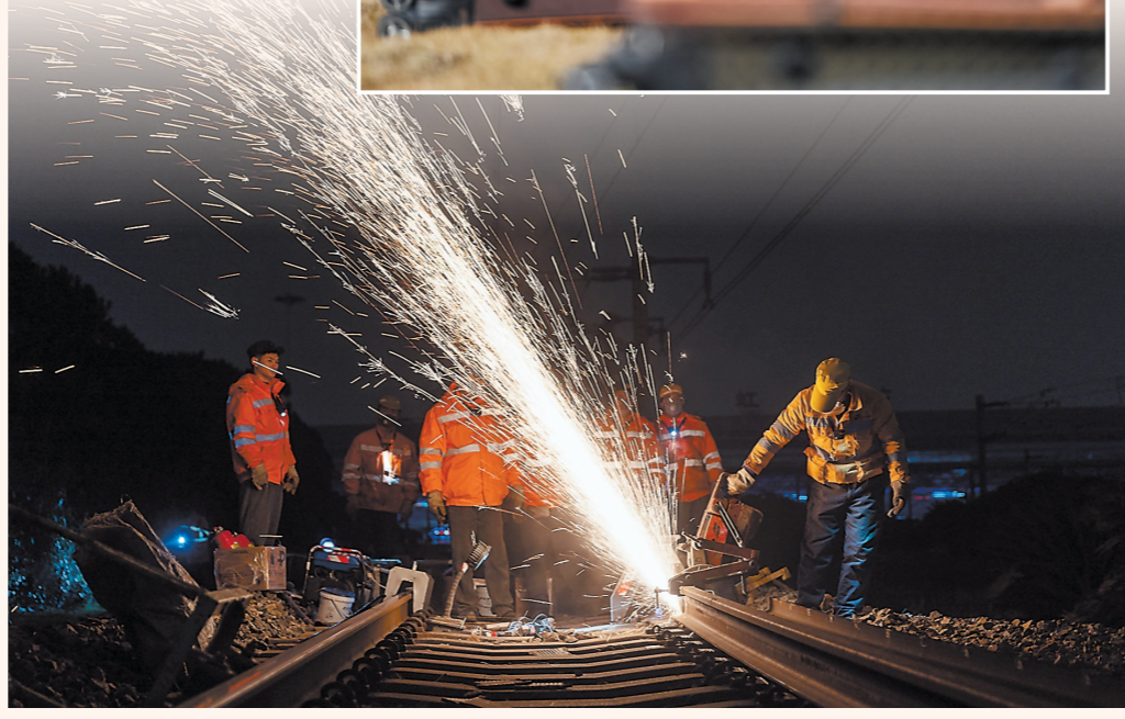
↓15日凌晨,中国铁路上海局集团有限公司上海工务段工人对上海虹桥站站区共计500米长的铁路钢轨进行换轨施工,为即将到来的春运行车提供安全保障。
