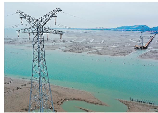
4日,位于福清的国内跨海架空线路距离最长的工程——220千伏赤厝至华塘线路工程顺利投运,跨海长度达14公里。这是国内现有跨海规模最大、密集度最高的架空输电线路工程。
