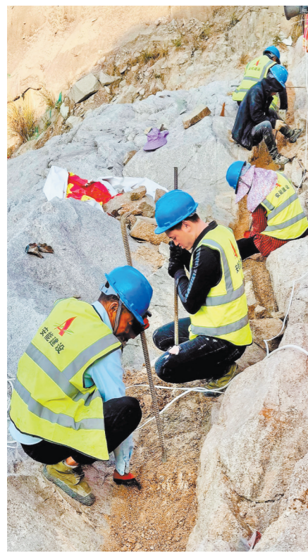
▲春节期间,罗源昌西水库工程施工现场,工人正在进行坝基处理。陈旻摄
