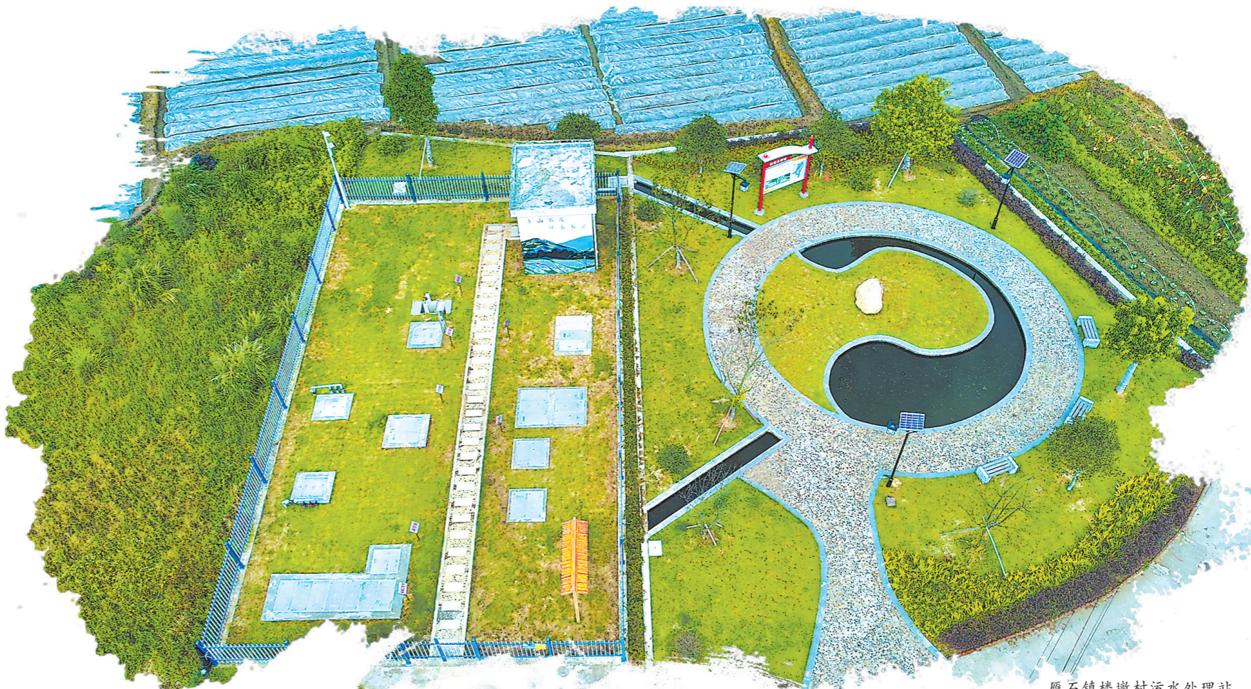
雁石镇楼墩村污水处理站
