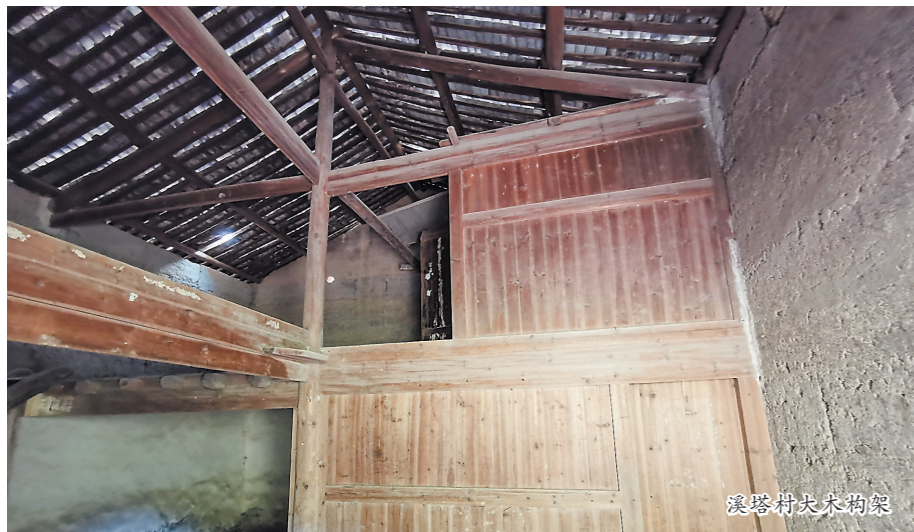
溪塔村大木构架
