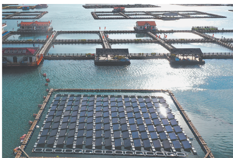
全省首个渔排“风光储微电网”示范项目在三都澳建成投运,可实现海上渔排不间断供电。
