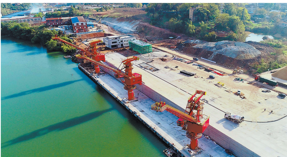
25日,三明港沙县港区青州作业区1#-3#泊位工程正在进行部分设施的收尾和内装修。目前已完成总工程量的90%以上。该项目新建500吨级通用泊位3个及相应配套设施,码头年货物吞吐量达55万吨,年设计通过能力为64万吨。
