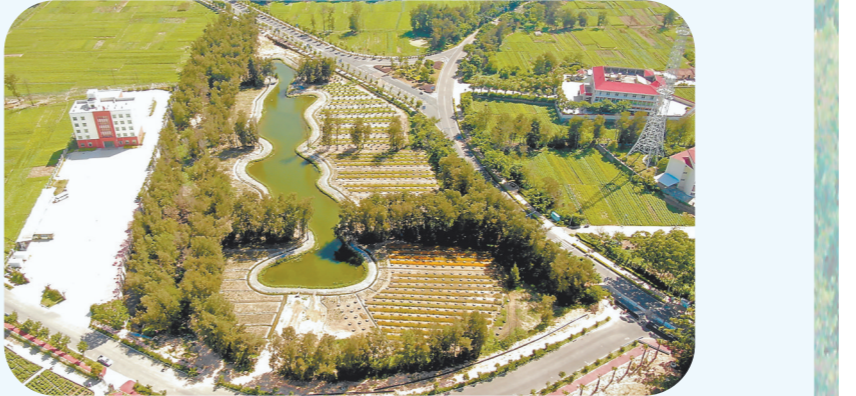
污水处理厂尾水蓄水池
